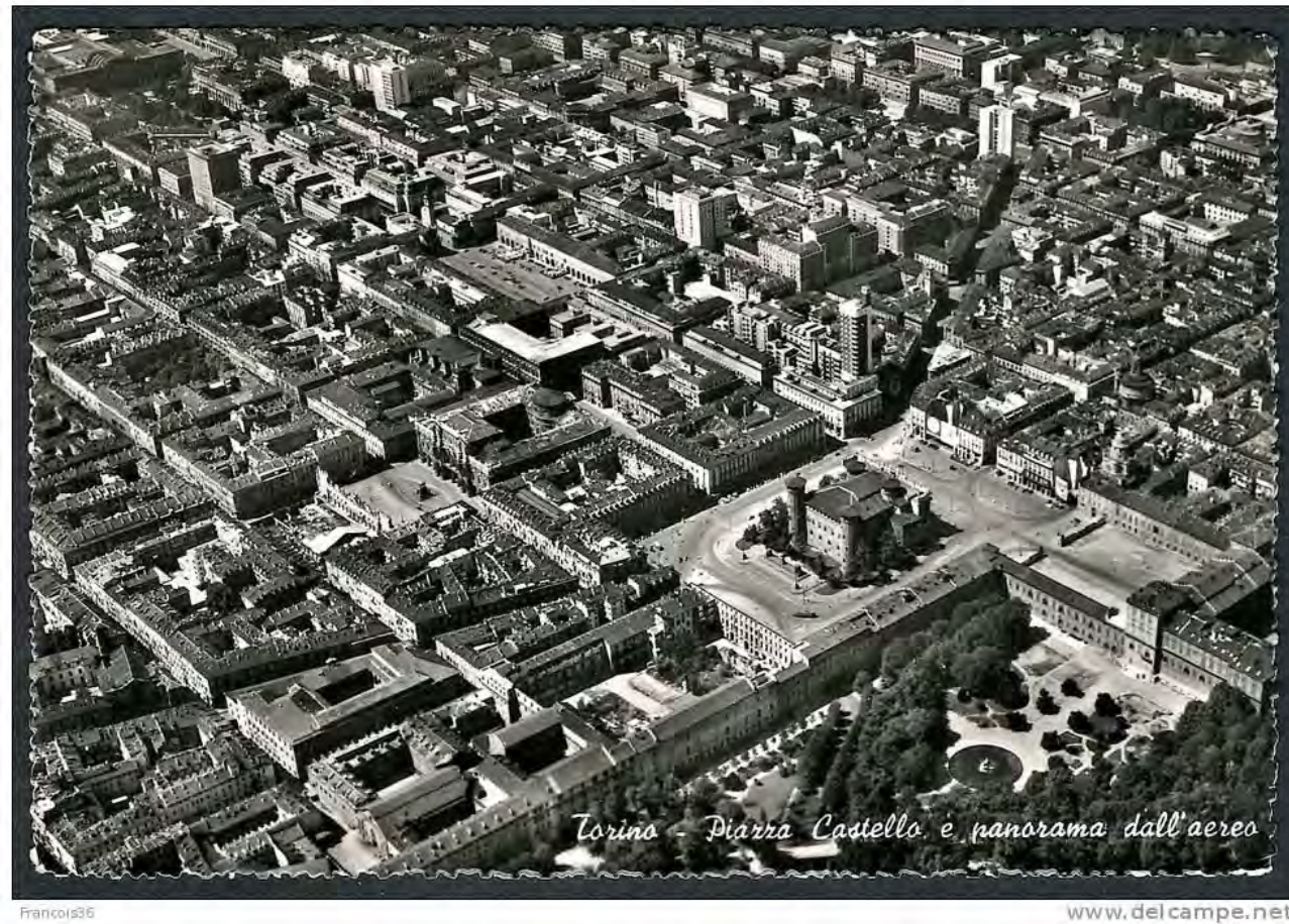
1955 | Ripresa aerea della Zona di Comando. Sono visibili i danni dell'incendio del Teatro Regio e bellici dell'Accademia Militare, mentre sussistono le facciate e la manica dei Dormitori dell'Accademia.
