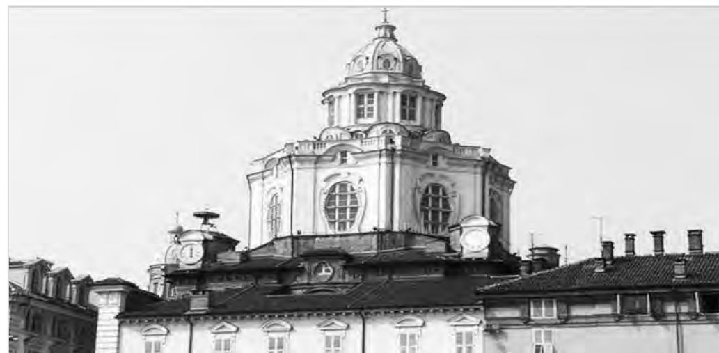
«Real Chiesa di San Lorenzo», edificata su disegno del Guarini sul parziale sedime della preesistente chiesa medievale di Santa Maria del Presepio (già Madonna della Neve).
