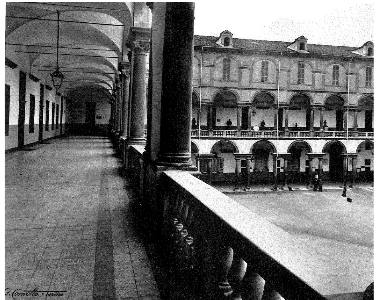
III.) Infilata prospettica del loggiato orientale e veduta parziale del lato meridionale
