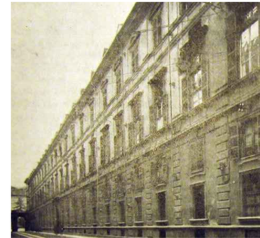
Foto storica del fronte su Via Verdi prima dei bombardamenti e demolizioni www.museotorino.it
